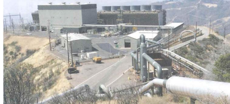
「The Geysers」(ガイザース)は米国のカリフォルニア州に位置し、米国で最大級の地熱発電地帯。1960年に地熱発電の商業生産を開始。現在は16の発電施設が存在し、総設備容量は約127万kW。カリフォルニア州の再生可能エネルギー由来電力の約20%を供給。
