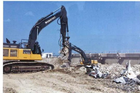
敷地内のガレキ処理状況。最後に残された排水溝付近の撤去。
