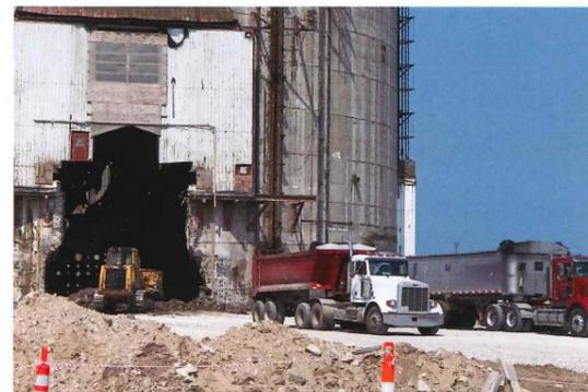
2つの原子炉建屋の解体工事が行われており、解体された施設跡を埋め戻すための土の運搬用トラック輸送が1日に約200台往來している。
