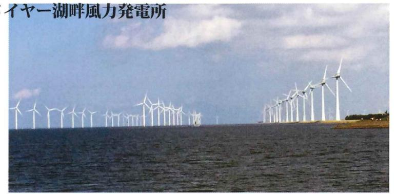
Westermeer は、内陸湖 (アイセル湖) の湖上発電プロジェクトである。この湖は、北海の内湾であったが、1932年完成の大堤防で北海と切り離されて、淡水湖になった。Siemens の3MW機 (ダイレクト・ドライブ) 48基で、144MWの出力規模である。岸壁から600mと1.2kmの距離に、17基ずつ2列、他に14基が1列である。水深は3~4mと浅く、内陸部を水上輸送するため、使用できる作業船に制約があった (湖に対応できる独自の工事機器を開発した)。内陸の淡水湖のため干満潮に水面変化はなく、波も穏やかである。はしご付きのTPを
